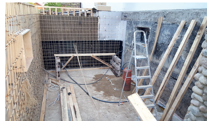
Деформационный шов отделяет новый фундамент от старого
